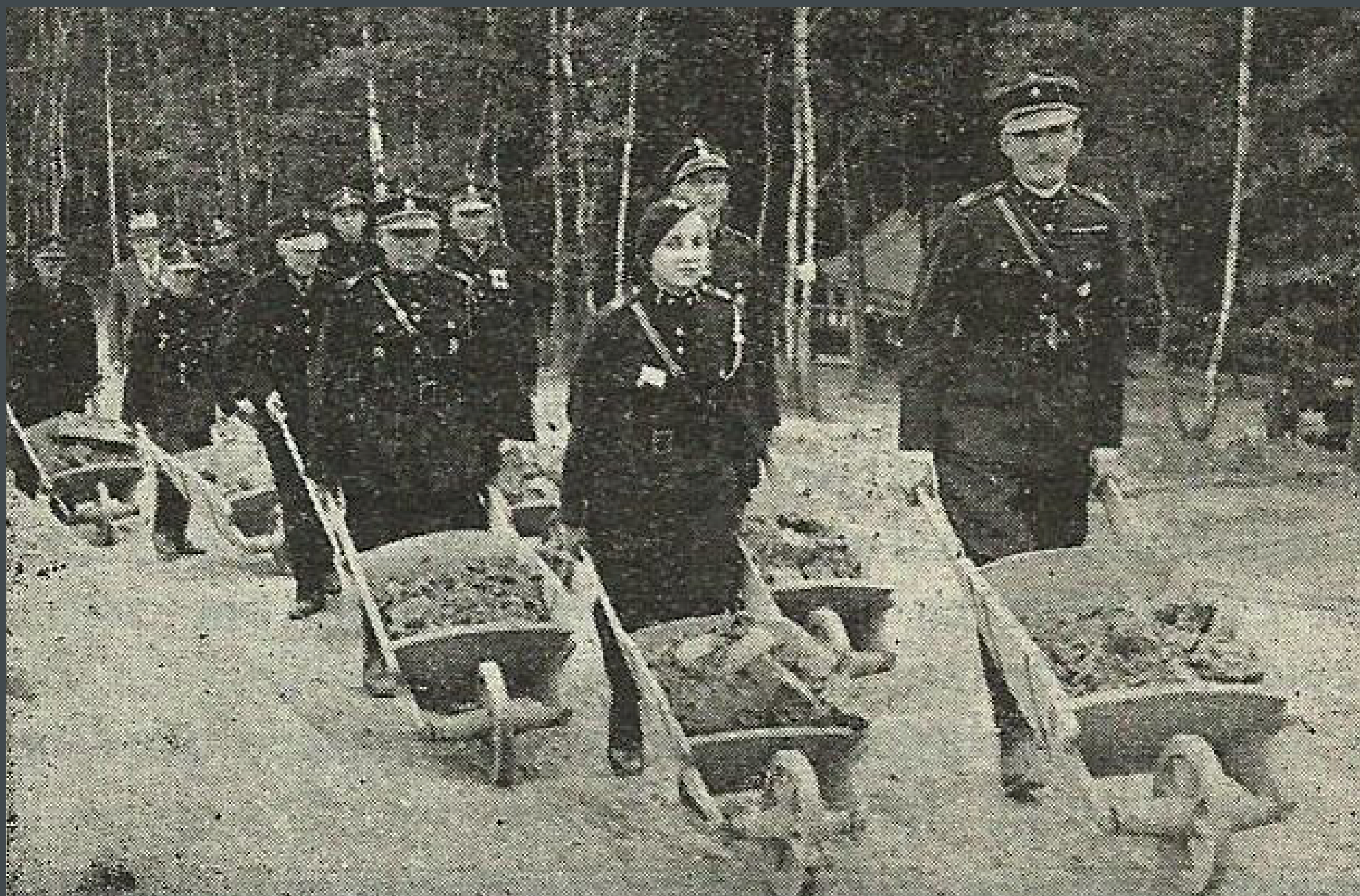
Budowa kopca Piłsudskiego, ok. 1935 r.
